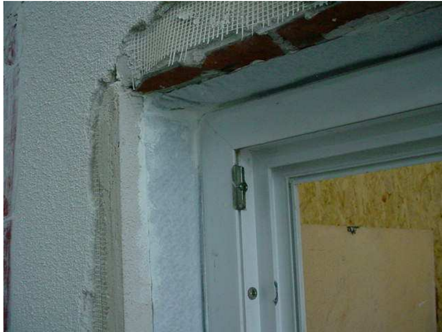
Bild 1 Raumseitige Abdichtung mit Fensterdichtband RS, Verklebung zum Baukörper mit Soudafoam 330D, überlappende Ausbildung im oberen Eckbereich
