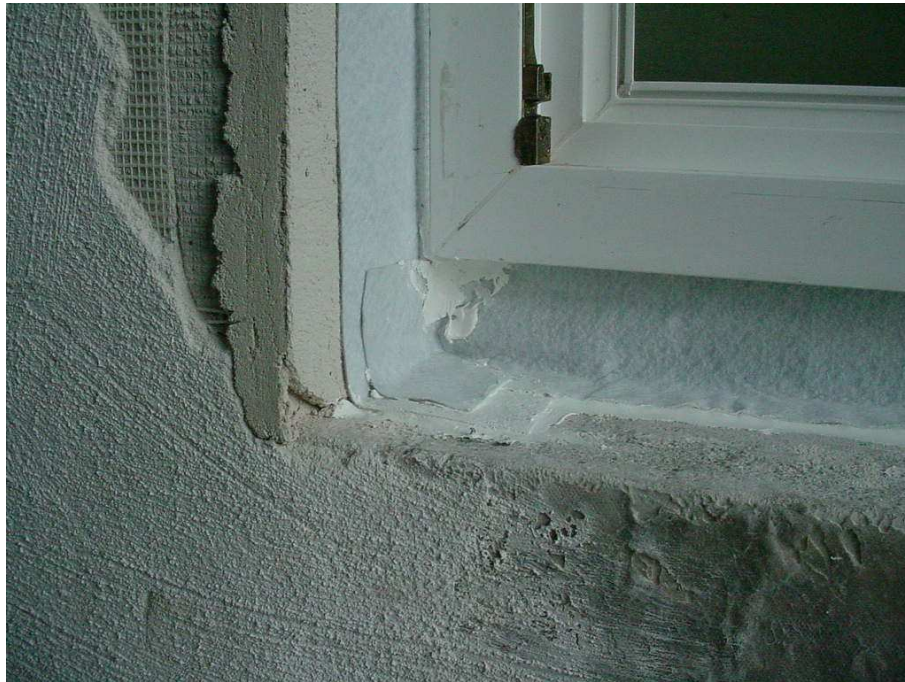
Bild 3 Raumseitige Abdichtung, untere Eckausbildung
