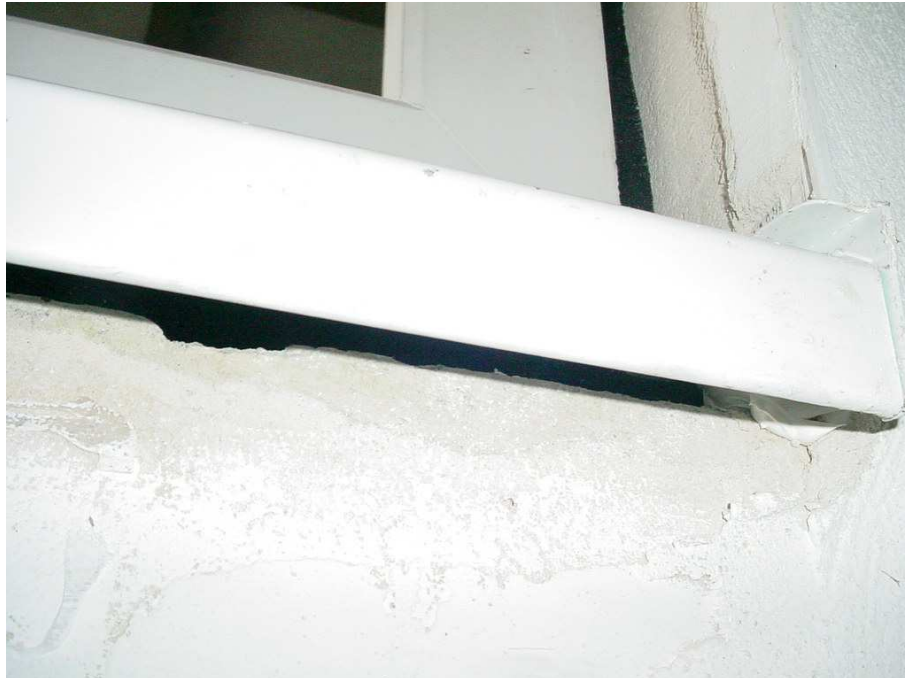
Bild 5 Außenseitige Abdichtung unterer Bereich, Fensterbank montiert (Ausführung für die Untersuchung der Schalldämmung)
