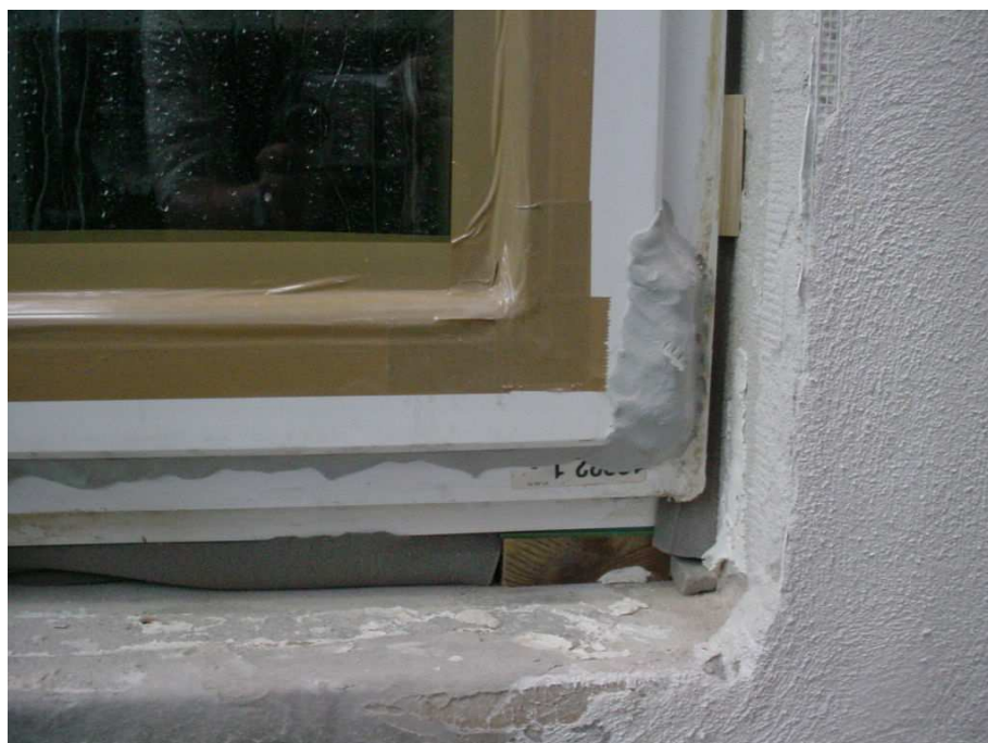
Bild 2 Fugendämmung mit Soudaband Acryl HF
